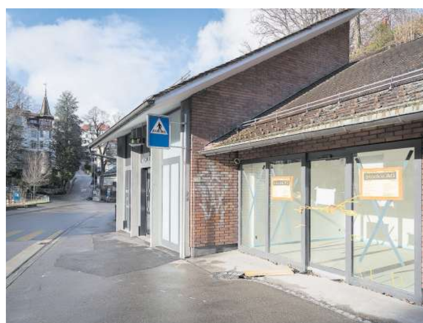
Die Umbauarbeiten für den Kiosk «Georg» laufen. Bild: Lisa Jenny
